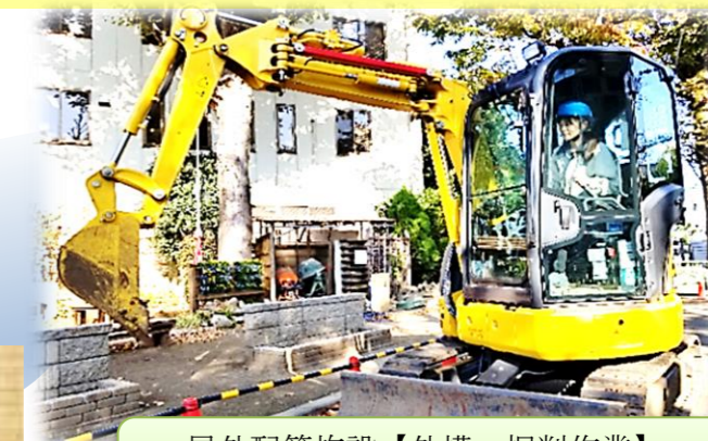
屋外配管施設【外構掘削作業】 (小型車両系建設機械運転特別教育)
