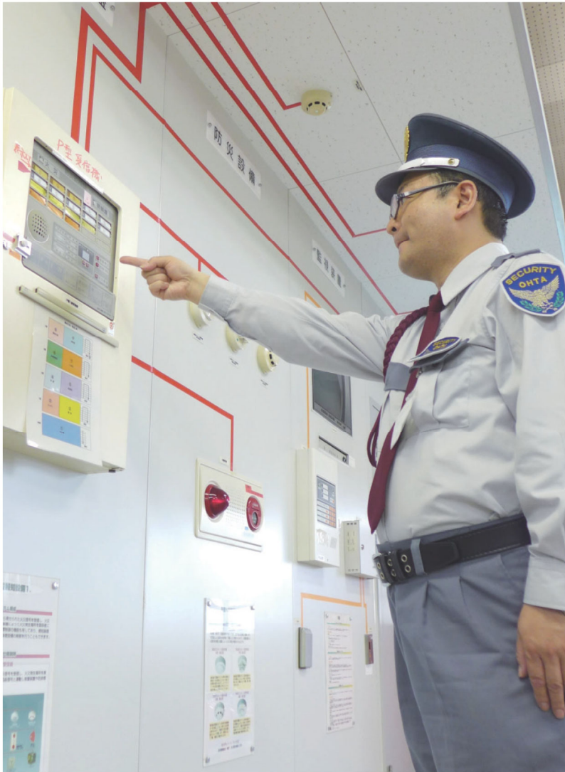
自動火災報知機の操作
