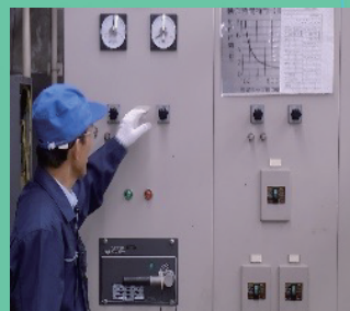
受変電設備作業
